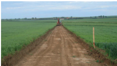
Ausbau der Wege auf mind. vier Meter Breite.
