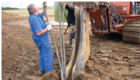
Einpflegen der Kabel in rund 1,20 Meter Tiefe.
