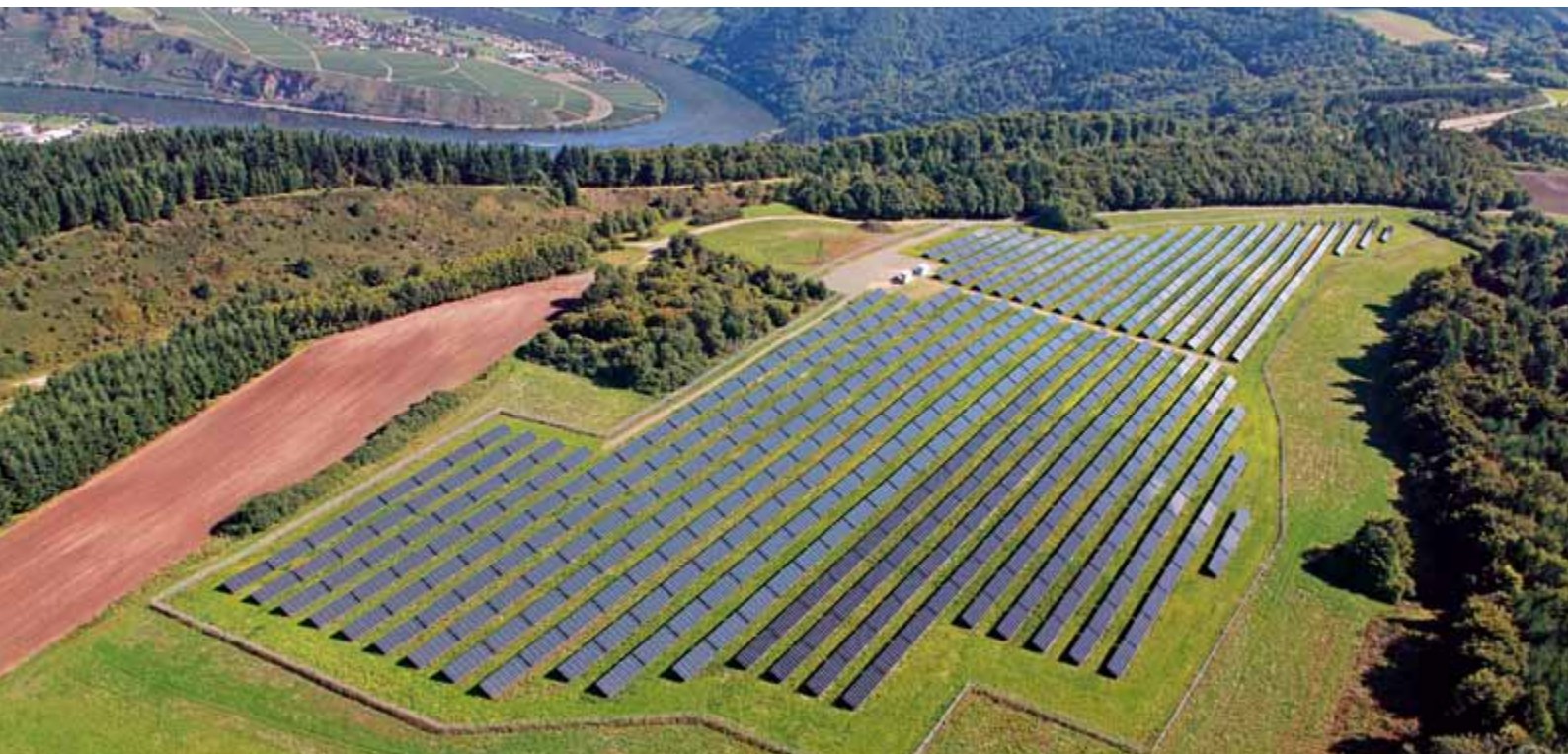
Photovoltaik im großen Stil: die Solaranlage oberhalb der Mosel bei Mehring.
