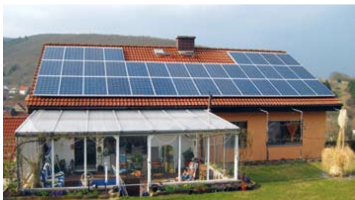
Einfamilienhaus Katzenbach (Rheinland-Pfalz)
