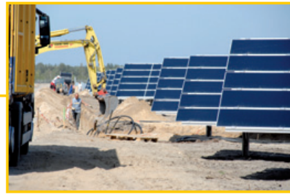
Ausheben des Kabelkanals
