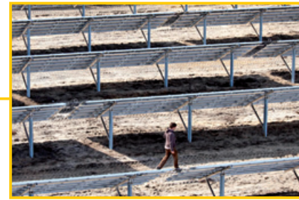
Unterkonstruktion eines Modultisches
