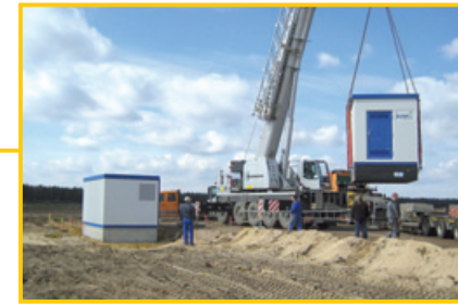
Anlieferung der Wechselrichterstationen
