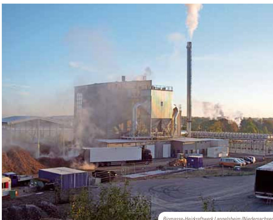
Biomasse-Heizkraftwerk Langelsheim (Niedersachsen)
