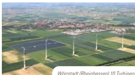
Wörrstadt (Rhein Hessen) 10 Turbinen
