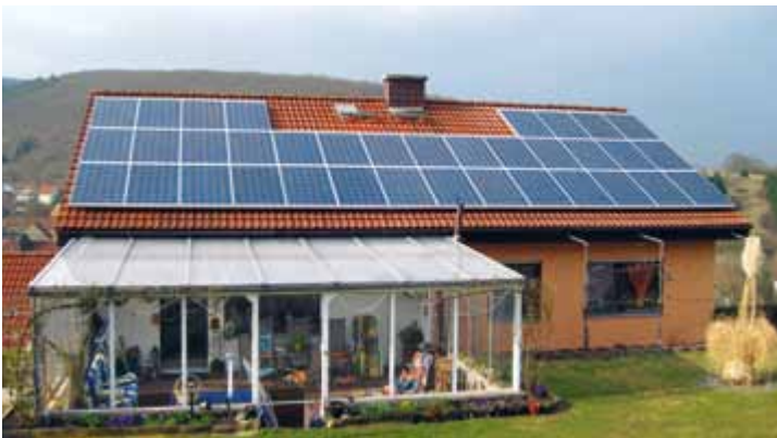
Einfamilienhaus Katzenbach (Rheinland-Pfalz)
