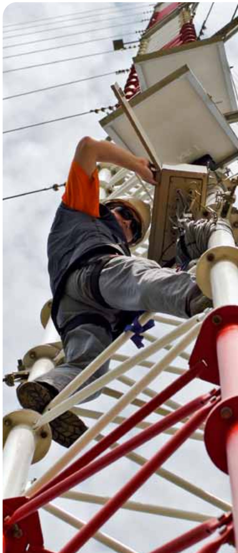
Arbeitsplatz in luftiger Höhe: Der Windhunter-Mitarbeiter Rafal Kramek beim Einsatz an einem 100 Meter hohen Gittermast.
