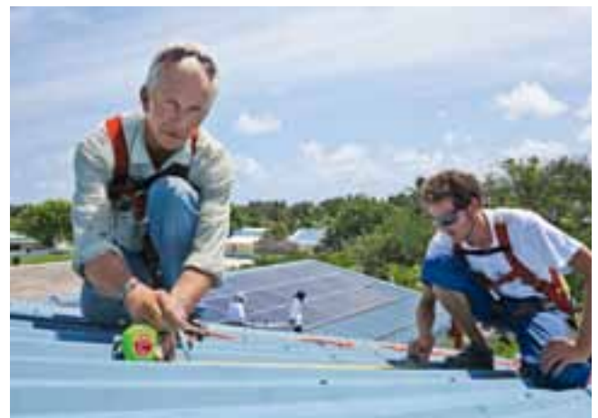
Norbert Borchert (l.) und Steffen Rauer beim Bau einer Photovoltaikanlage auf den maledivischen Inseln.
