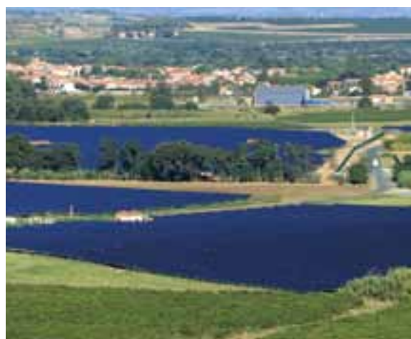
Der 25-Megawatt-Solarpark Ortaffa in den Pyrenäen.
