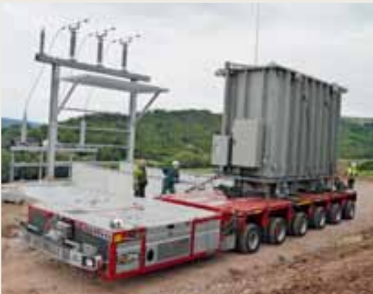
Für den Transport dieses Trafos musste ein 500-PS-Fahrzeug ran.
