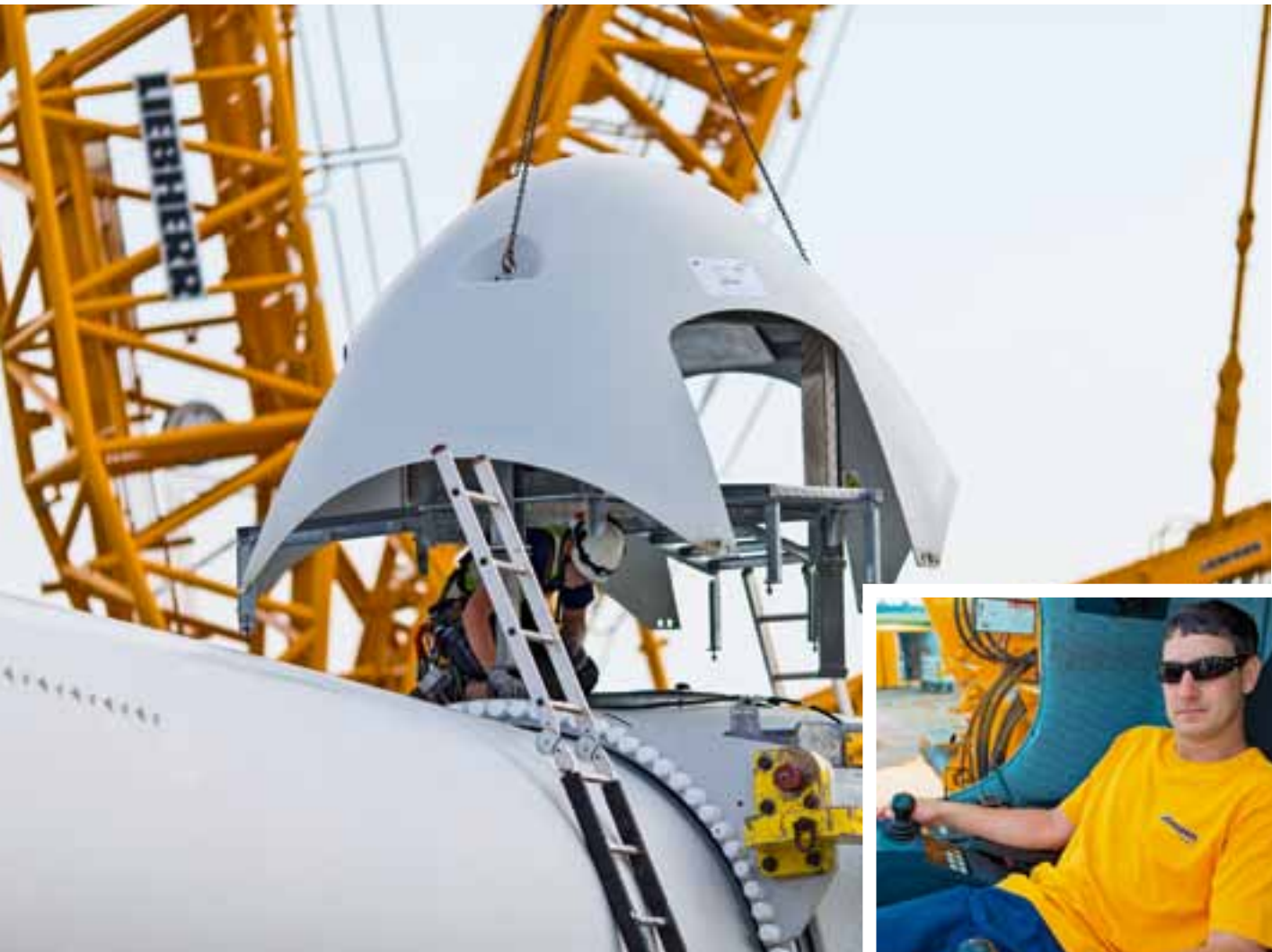
Auf der Baustelle werden die Flügel am Boden mit der Nabe verbunden. Ist der Rotor vormontiert, kann der gesamte Stern gezogen werden. Christian Fitz steuert den Kran.
