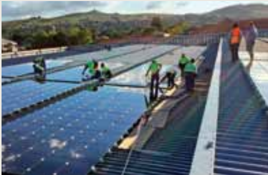
Auf einem Parkdeck in Pretoria hat juwi die Anlage gebaut.
