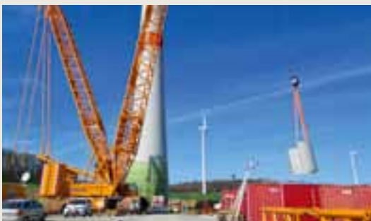
Im Frühjahr 2017 wurde die Windenergie-Anlage gebaut.
