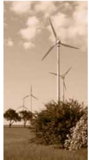
Seit 20 Jahren sind die fünf Enercon-Anlagen in Spiesheim in Betrieb.
