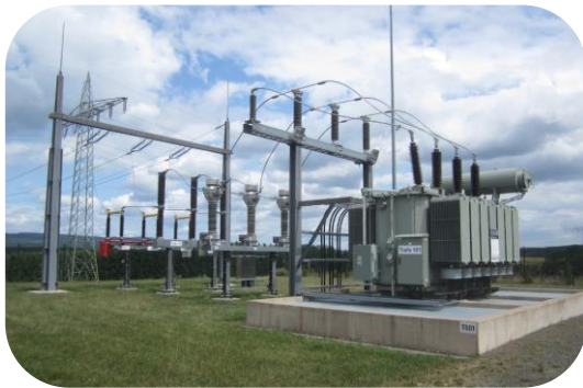
Neubau eines UWs
