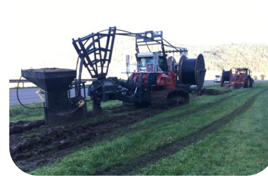
Kabelverlegung mit Kabelpflug
