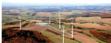
Eine Mitte der 1990er Jahre installierte E-66 wurde dafür abgebaut. Mit dem Austausch hat sich der Stromertrag versechsfacht.
